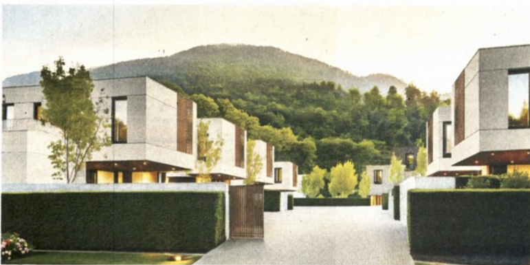
V Šmartnem pod Šmarno goro v podjetju Lumar IG za zasebnega investitorja razvijajo trajnostno zasnovano naselje z 21 montažnimi lesenimi hišami. © Lumar IG
